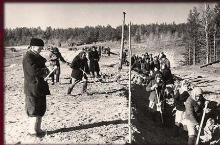
Земляные работы на строительстве
